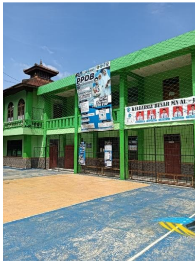
Gambar 1. Gedung Sekolah MA Al-Jawami
